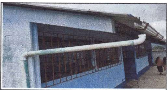
Foto 6: Sustitución de soporte o pescante de metal para canal.
