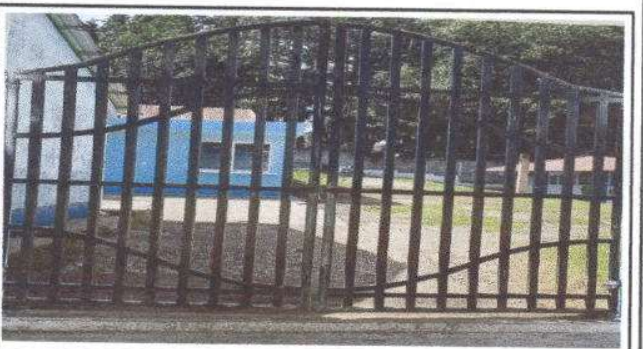
Foto 10: Mantenimiento a portón de metal
