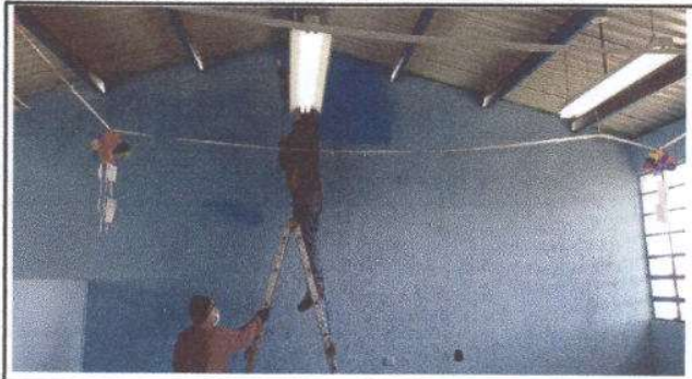
Foto 2: Reparación del sistema eléctrico.
