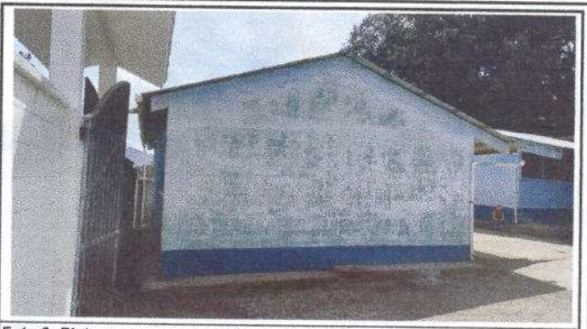
Foto 8: Pintura en muros exteriores e interiores
