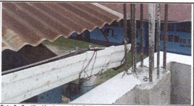
Foto 5: Sustitución de canal de PVC y accesorios
