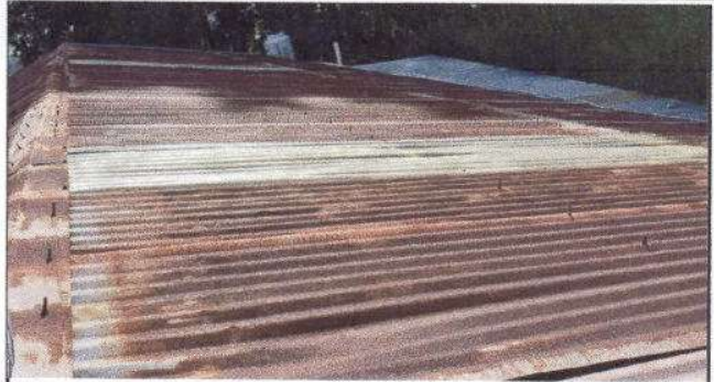
Foto 2: Sustitución de elementos de fijación
