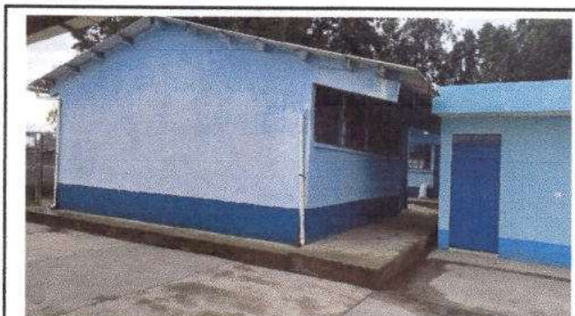
Foto 4: Sustitución de bajadas de agua pluvial tubo pvc 3" y accesorios
