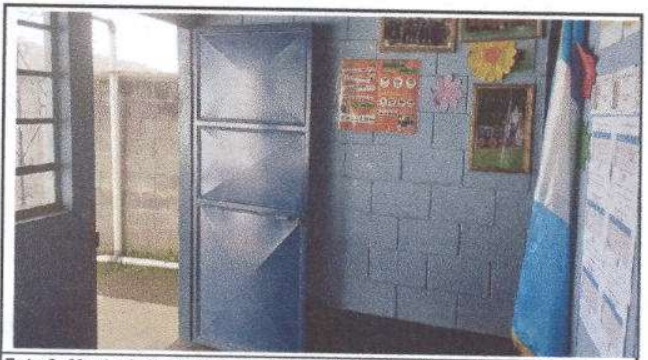
Foto 9: Mantenimiento de estructura ( lijado, cambio de tubo, cepillo sujeciones, aplicación de pintura)
